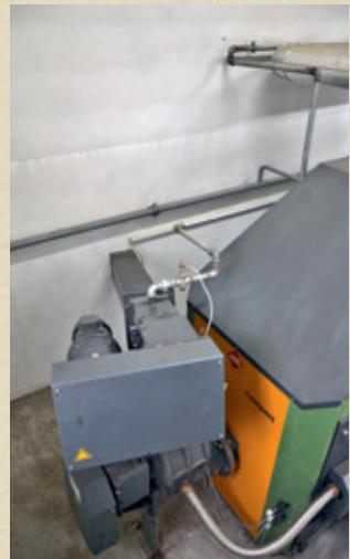
Kotao snage 150 kW sa sustavom automatskog doziranja drvene sječke
